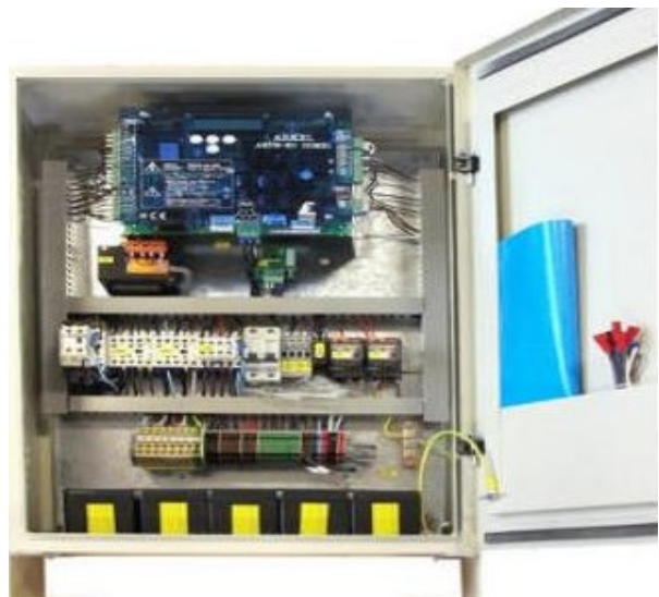
Şəkil 1.6. Mərtəbəyə çağırış sisteminin idarə dövrəsi
