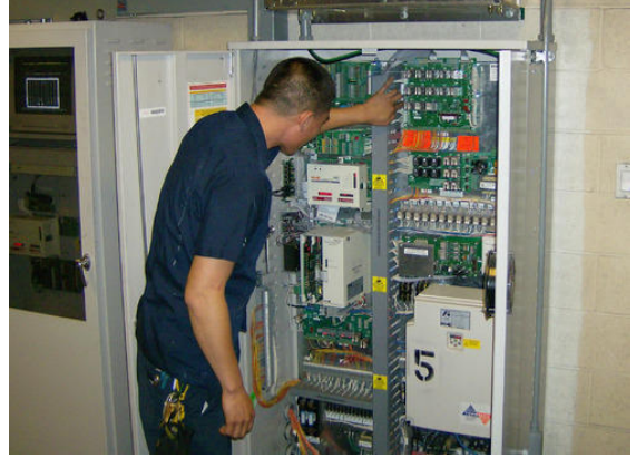
Şəkil 2.3. İdarəetmə şkaflı vizual yoxlamanın aparılması
