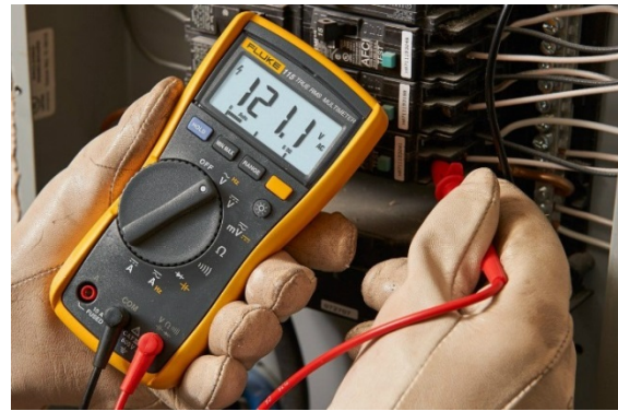
Şəkil 1.21. Giriş qurğusunda müqavimətin multimetrlə ölçülməsi
