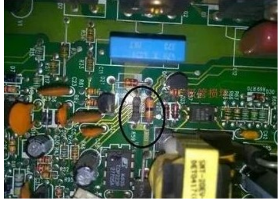
Şəkil 1.27. Elektrik platasında qısaqapanma səbəbilə sıradan çıxmış dövrə
