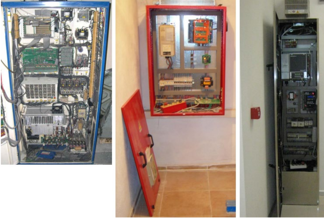
Şəkil 1.5. İdarəetmə panelləri
