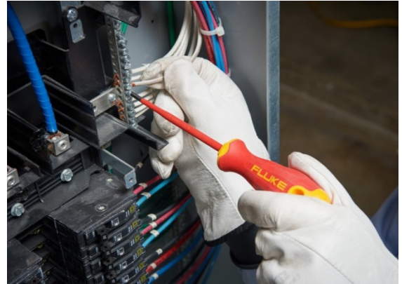
Şəkil 1.8. Liftlərin elektrik blokunda birləşmə yuvalarının bərkidilməsi
